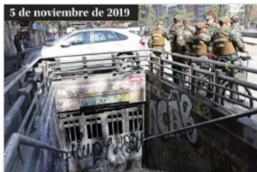
La puerta cercana al Teatro de la U. de Chile, afectada por el vandalismo.
