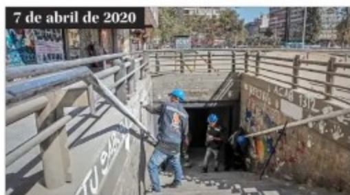
La empresa aún realiza faenas en el mismo acceso, como en los otros.
